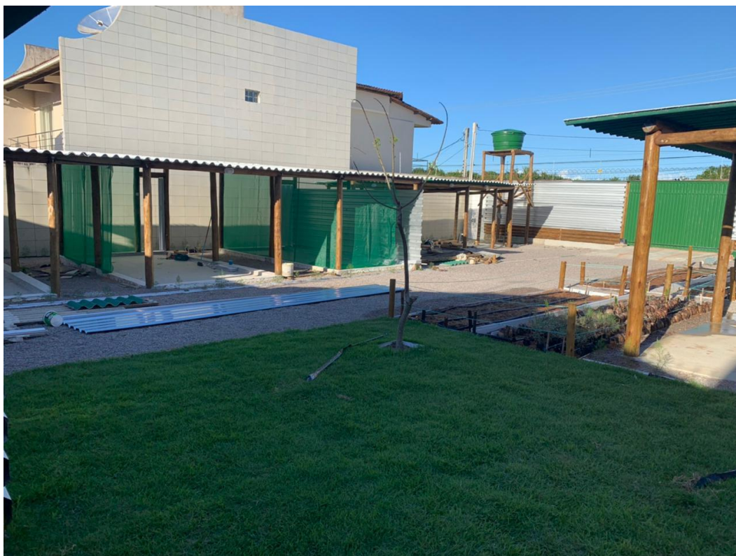
Figura 8. Estrutura Modular em Eucalipto Tratado
