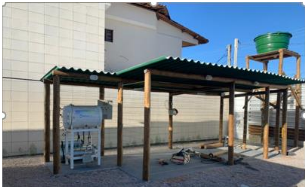
Figura 8. Estrutura Modular em Eucalipto Tratado da área da Caldeira e Caixa d'água
